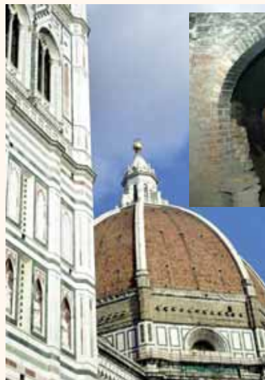
la cupola di Santa Maria del Fiore realizzata dal Brunelleschi con le terrecotte d'Impruneta
